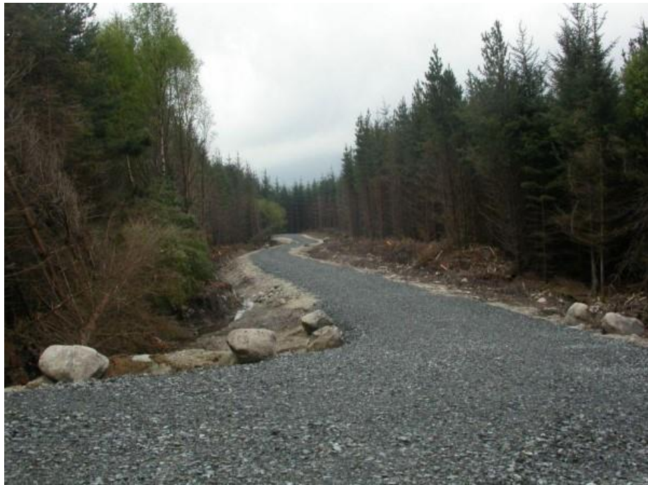
Рис. 5.13 – Відібраний крупний кам'яний матеріалі в процесі влаштування земляного полотна лісової дороги
