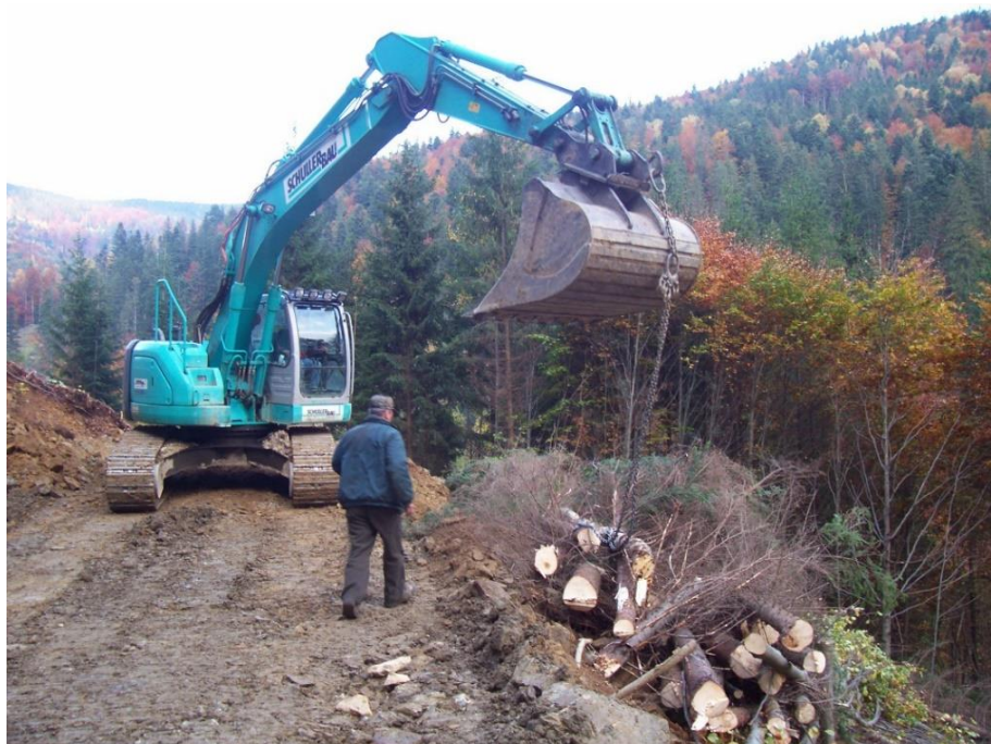
Рис. 5.10 – Переміщення зрубаних дерев з дорожньої просіки
