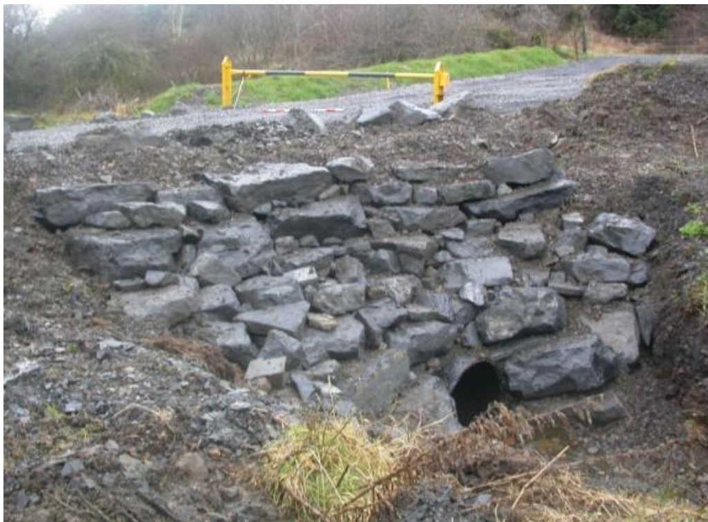
Рисунок 5.16 – Укріплення отвору водопропускної труби бутовим каменем
