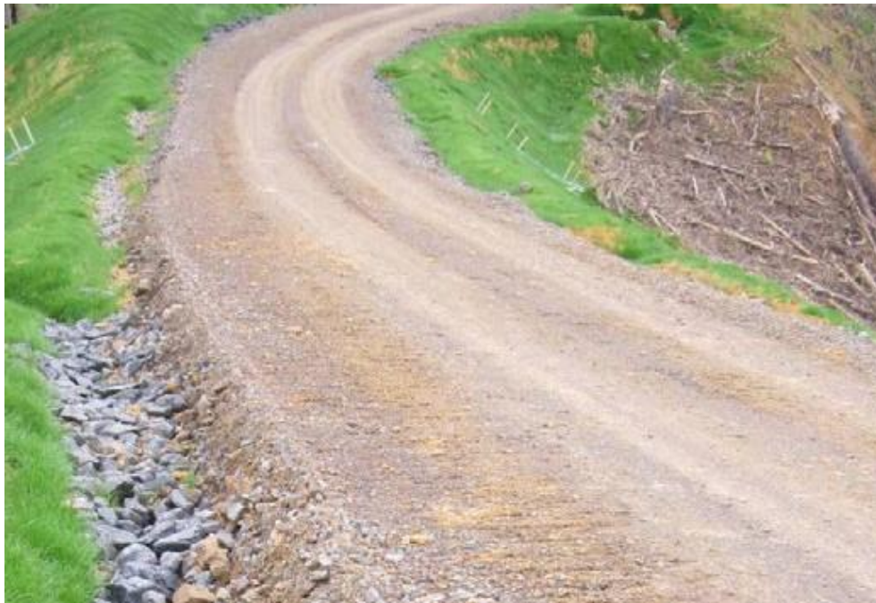
Рис. 5.15 - Укріплення місця виходу водовідвідної канави та укосів земляного полотна місцевими матеріалами
