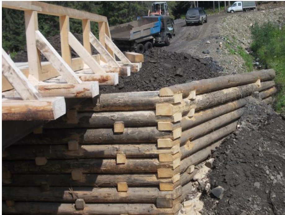
Рис. 5.14 - Будівництво дерев'яного моста на лісовій дорозі
