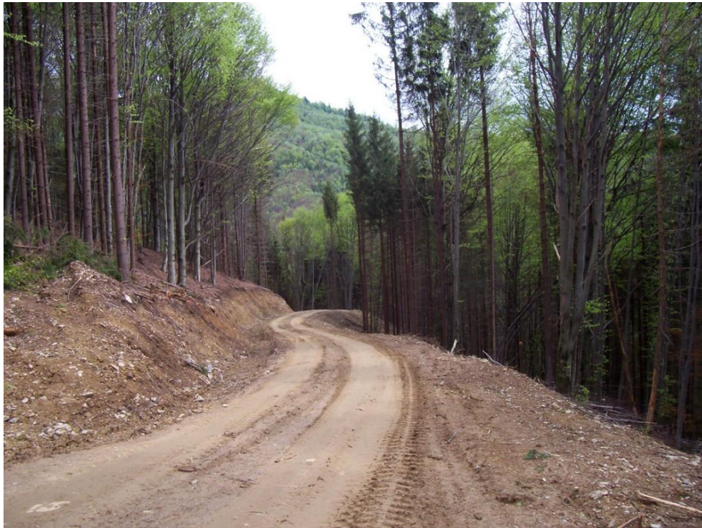
Рис. 5.12 – Завершене земляне полотно лісової дороги
